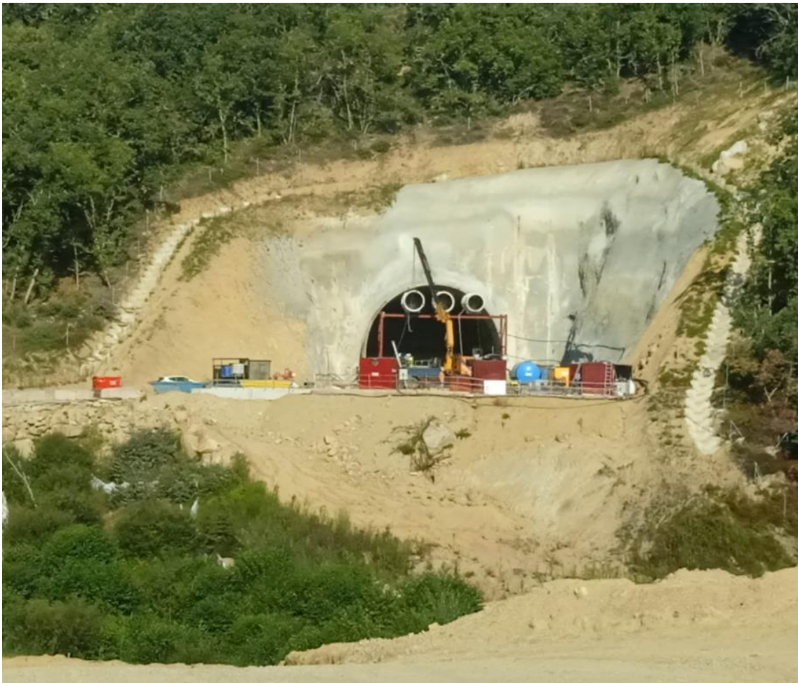
Foto 06. Túnel de Rante.
