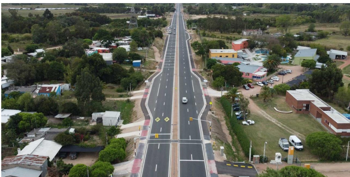
Foto 29. Proyecto Cuchilla Grande. Finalización del tramo.
