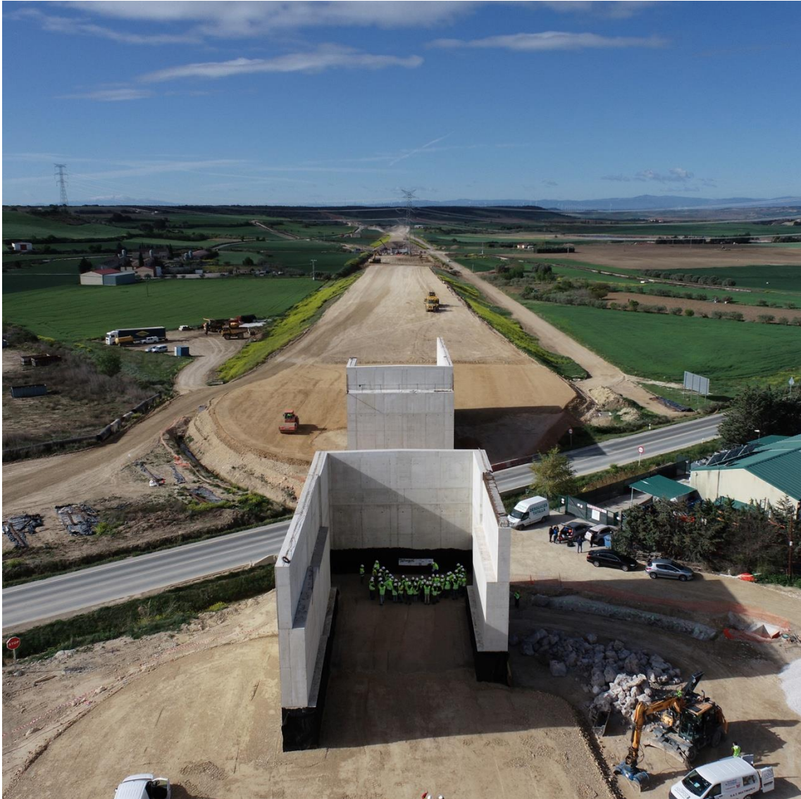
Foto 08. Ejecución plataforma del AVE en Tafalla.
