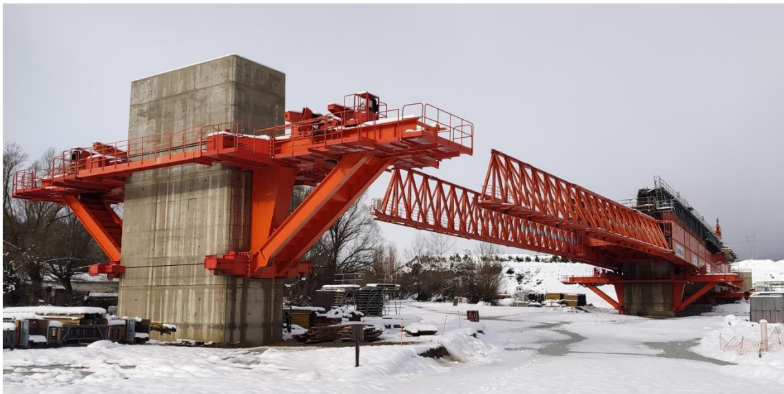
Foto 01. Obra de Sabiñánigo.
