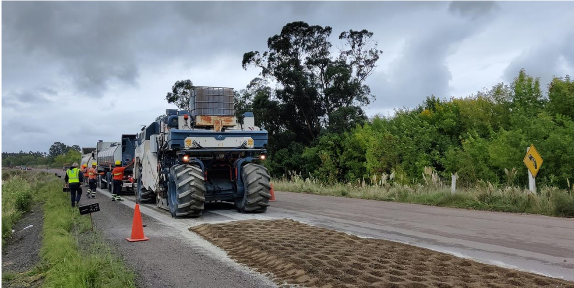
Foto 30. Proyecto Cuchilla Grande. Ejecución.
