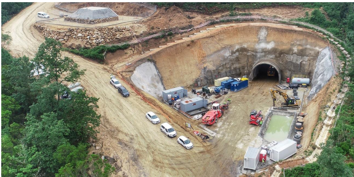
Foto 02. Construcción de plataforma del AVE tramo Túnel de Rante – Conexión Seixalbo.
