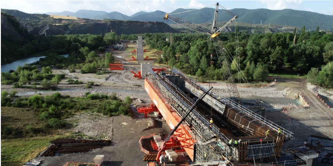
Foto 10. Obra de Sabiñánigo.
