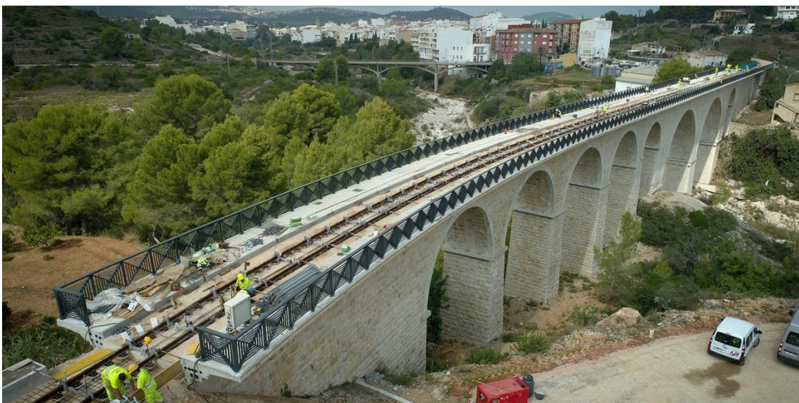
Foto 07. Renovación y acondicionamiento línea 9 del TRAM, tramo Teulada - Gata.
