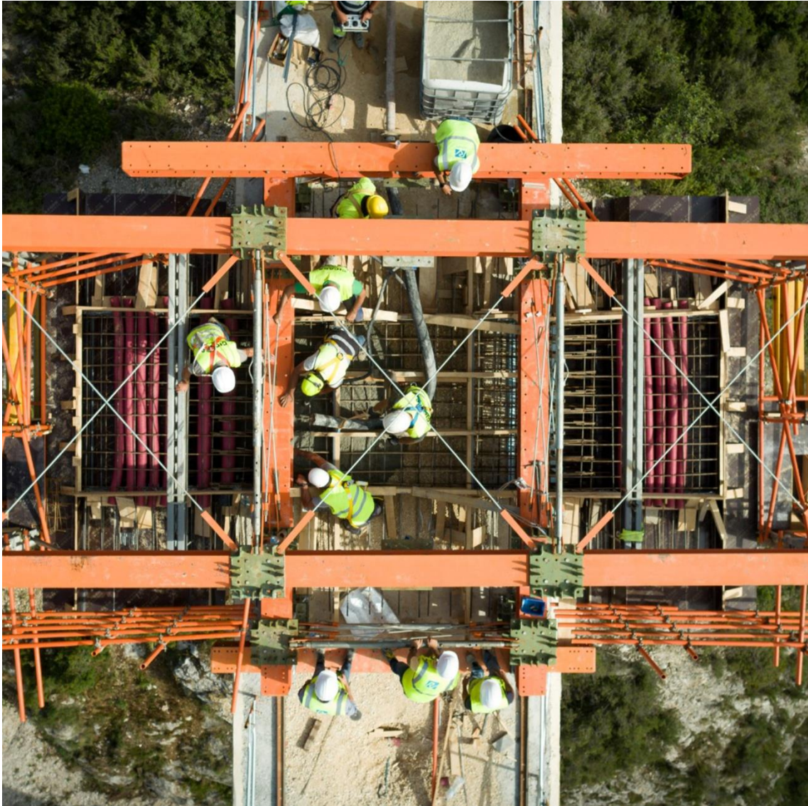
Foto 06. Renovación y acondicionamiento línea 9 del TRAM, tramo Teulada - Gata.
