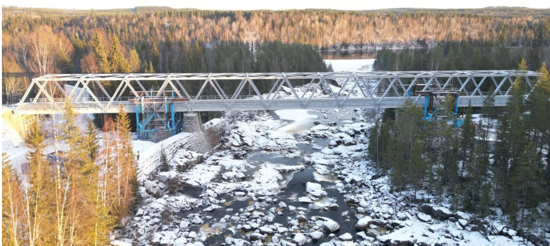
Foto 21. Puente ferroviario en Sollefteå.
