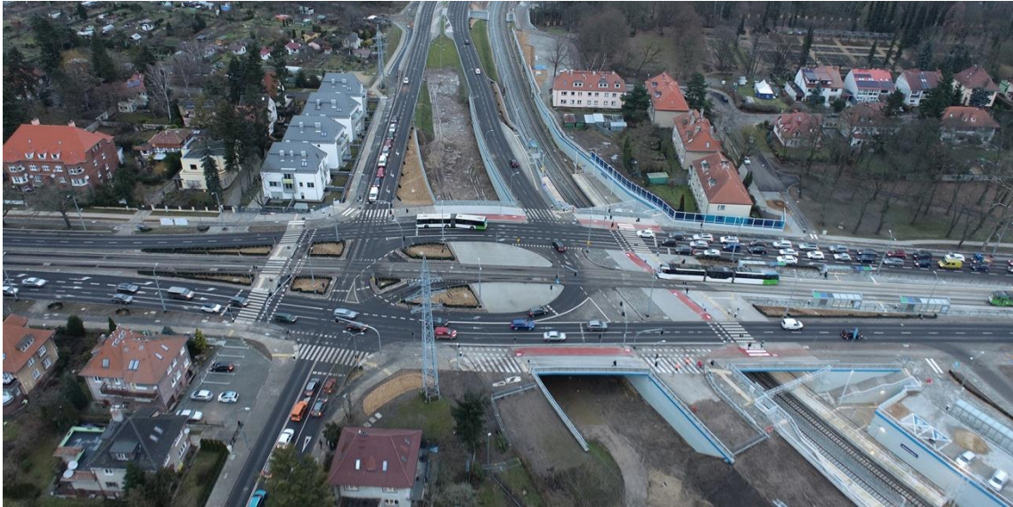
Foto 16. Enlace de transporte integrado Szczecin Łękno.
