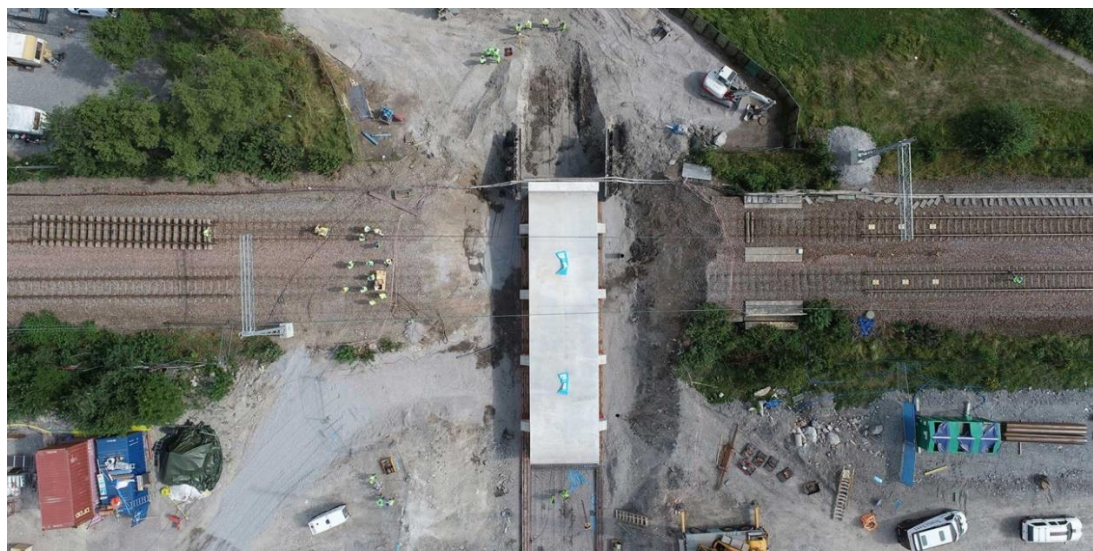
Foto 23. Proyecto Culvertering Spångaån.
