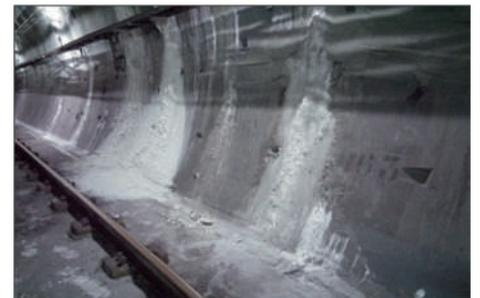
Vista de filtraciones entre dovelas del túnel antes de la ejecución del proyecto
