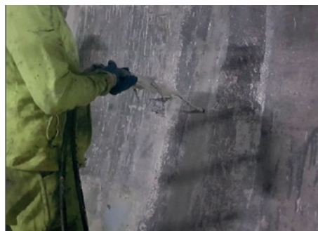
Aplicación final imprimación sobre juntas en tramo de prueba
